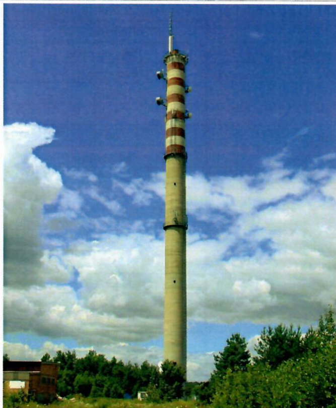
Fot. 1. PŁOCK - TARTACZNA – widok komina z antenami
