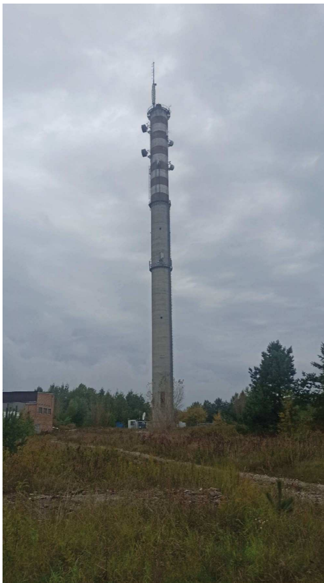
Zdjęcie 1 Badany obiekt
