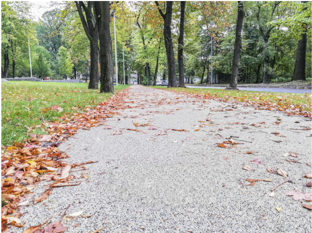
Fot.8. Nawierzchnia Ekoway
