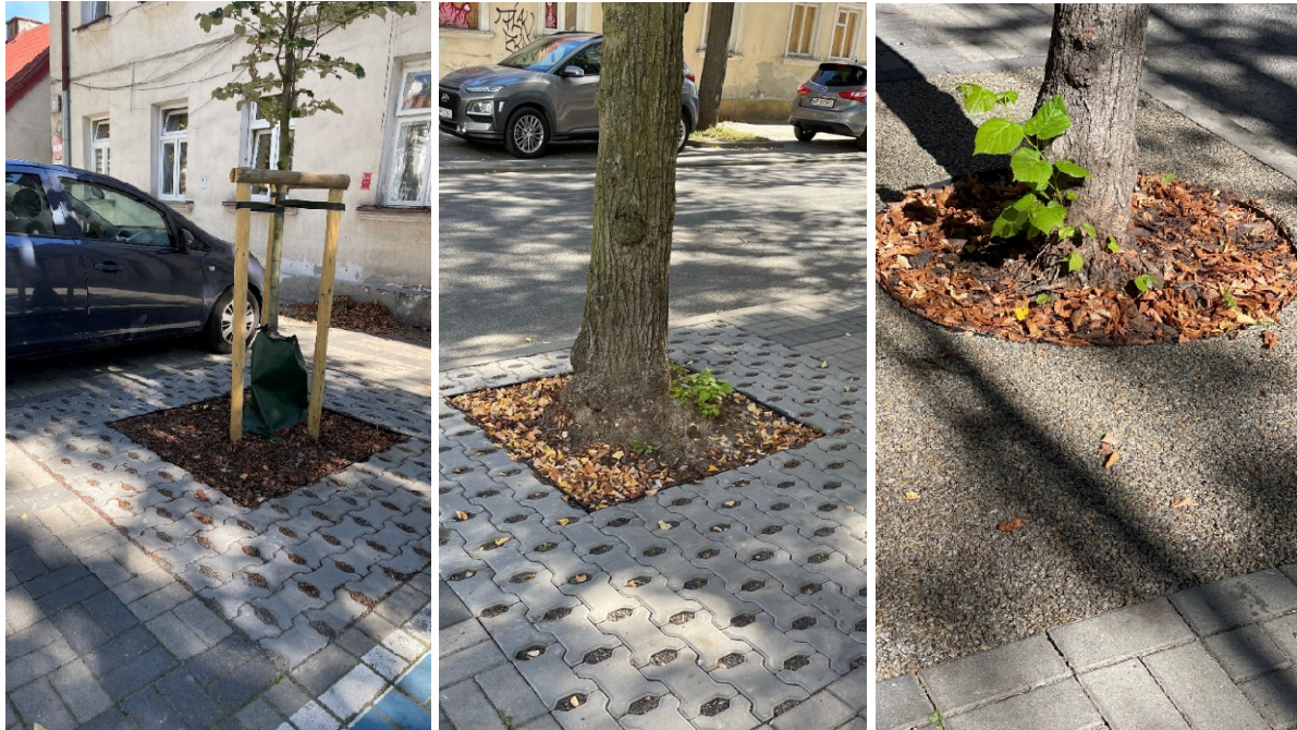
Fot. 2. Drzewo nowo posadzone (pierwsze z lewej) i drzewa z wymienionymi nawierzchniami na ul. Kazimierza Wielkiego. Rodzaje zastosowanych nawierzchni – Teraaway, Ekoway, Hanzaway, Hans Grand, Kostka Domino Eco
