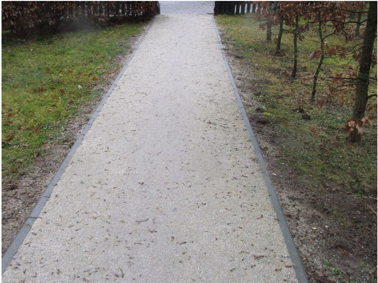
Fot. 10. Nawierzchnia HanseGrand
